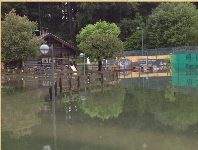
Die Tennishütte ist vom Wasser komplett umgeben. Wie durch ein Wunder ist der Keller nur bis zu 25 cm gefüllt.
