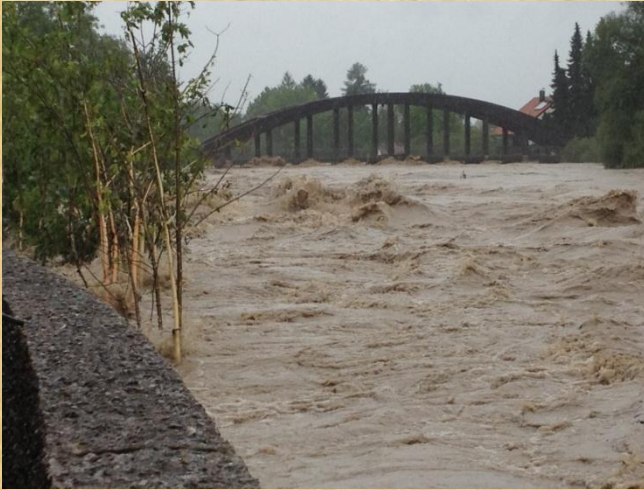
Pegelhöchststand der Tiroler Ache am 2. Juni. Im Hintergrund sieht man die alte Achenbrücke.
